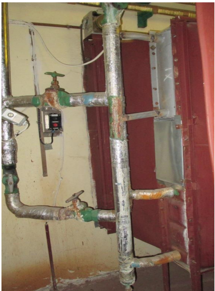
Рис 1.13 – Трансформаторная мастерская. Арматура системы теплоснабжения калориферов устарела.
