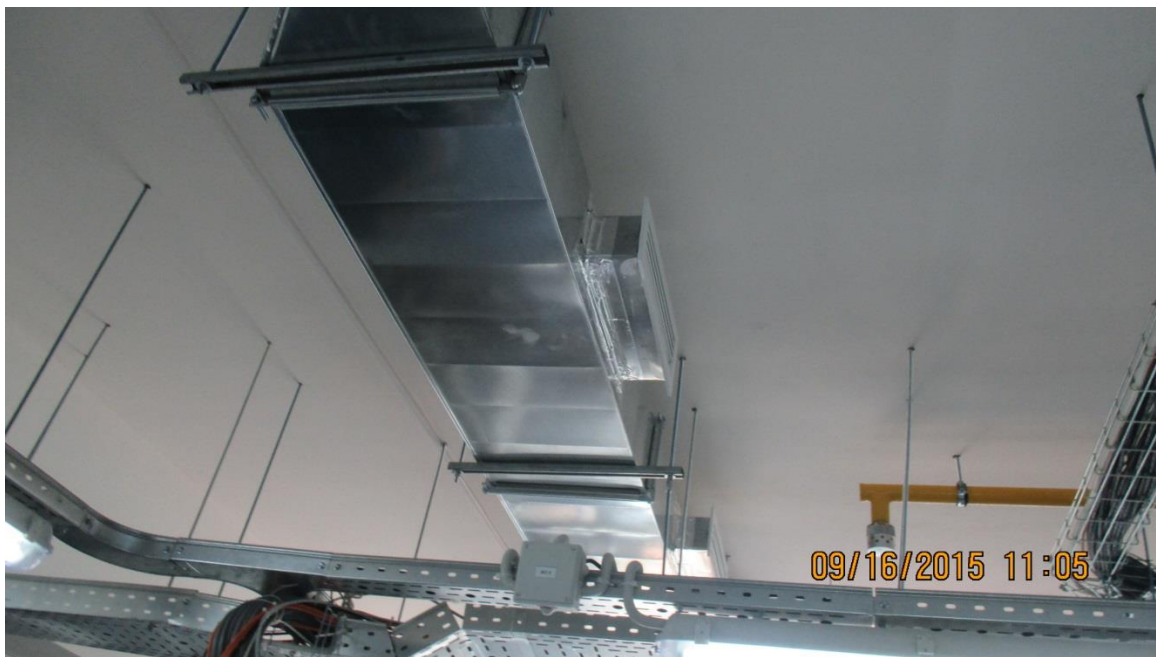
Рис 1.4 – СПК, бэт. Реконструкция вентиляции серверной проведена успешно, оборудование работает в штатном режиме.
