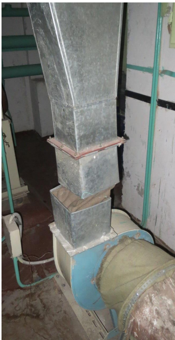
Рис 1.3 – СПК; Вентсистема BC5 смонтирована не аккуратно, воздуховоды устарели.
