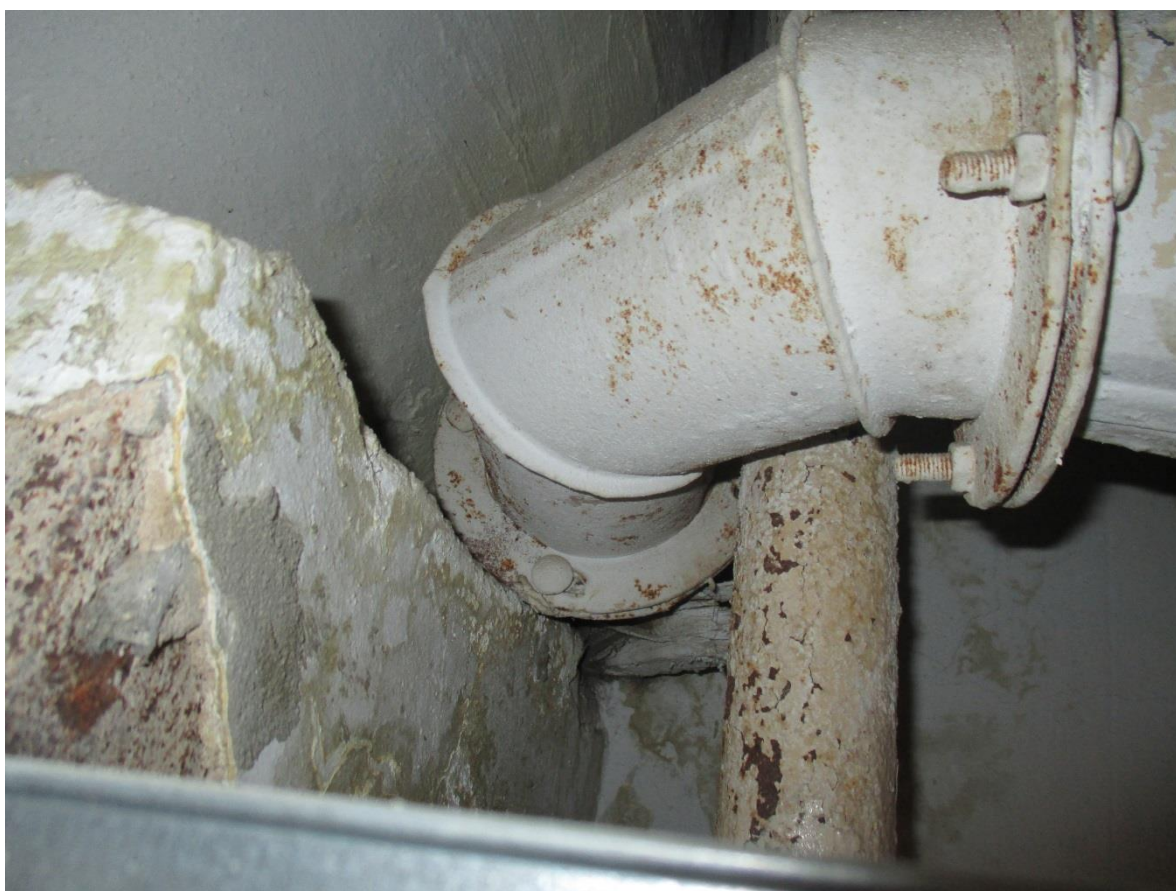
Рис 1.2 – СПК, 3эт; вентиляционные системы устарели;
