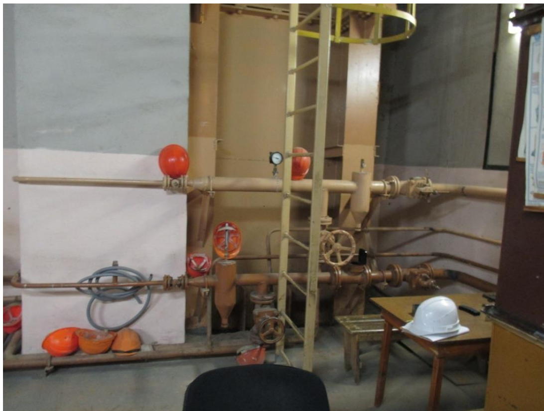
Рис 1.12 – Здание ГАЭС, тепловой узел.
