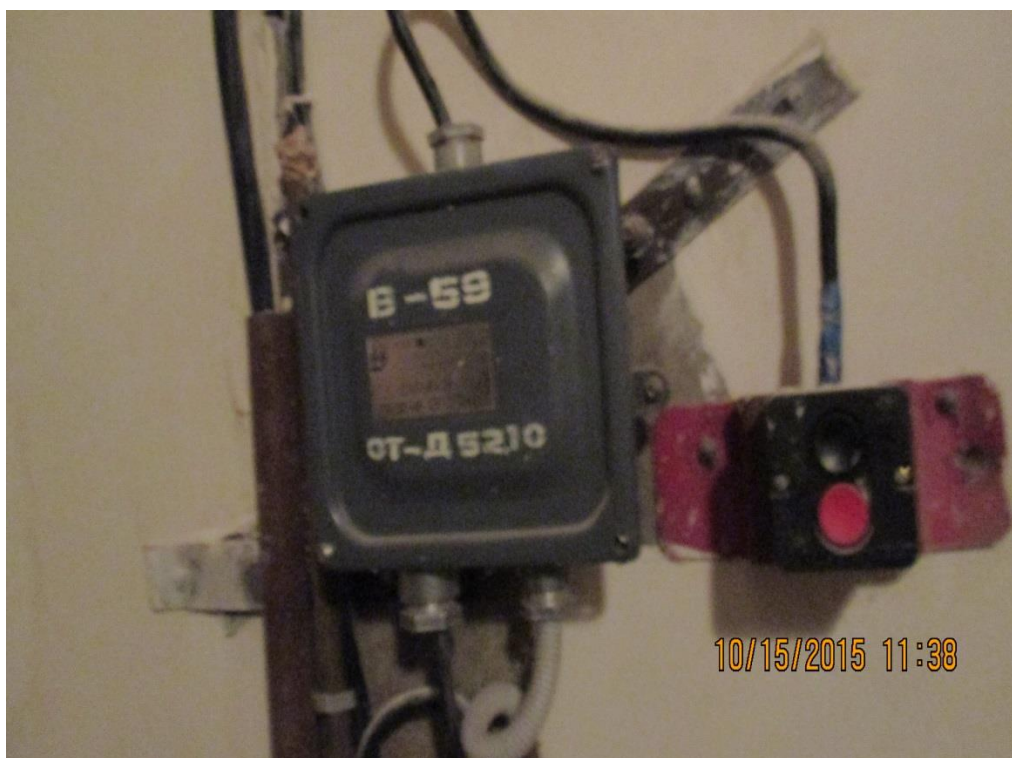
Рис 1.8 –Оборудование управления ОВ устарели, требует обновления и замены.
