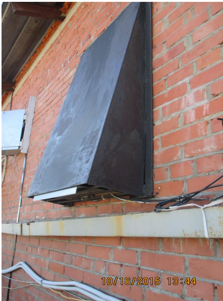
Рис 1.9 – Водоприемник. В зимнее время заборные решетки системы П9 закрыты;
